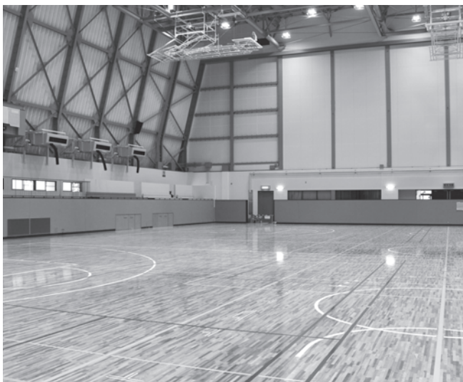
エアコンが増設された大体育室
