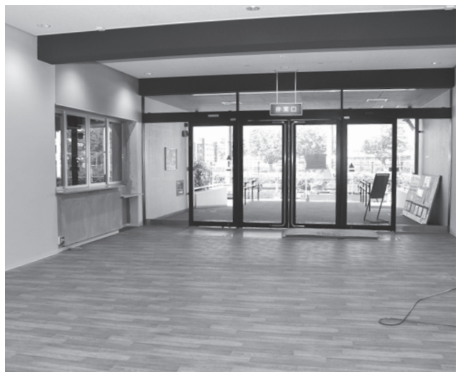
床が貼り替えられたエントランス
