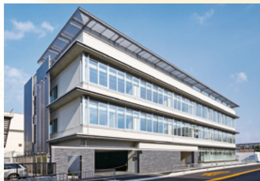
上下水道庁舎
