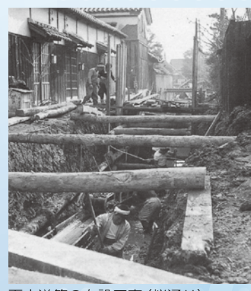
下水道管の布設工事 (桜通り)
