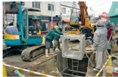
雨水管の布設状況
