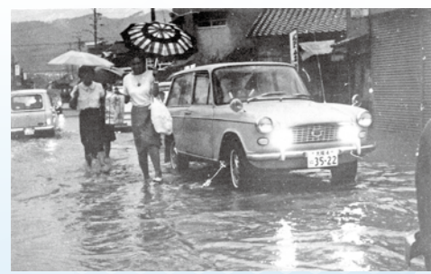
下水道整備前の浸水状況
