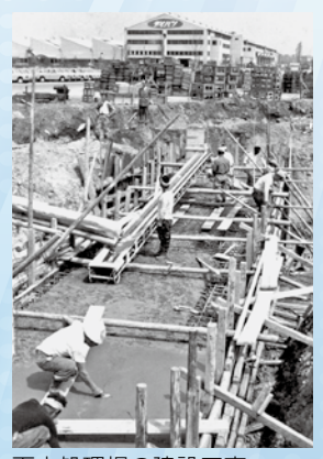
下水道処理場の建設工事
