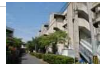
池田市営 井口堂住宅
