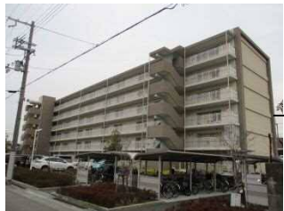
大阪府営 池田城南住宅
