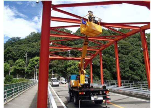
高所作業車を用いた点検
