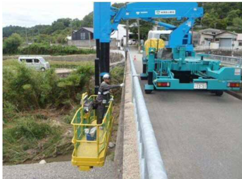
橋梁点検車を用いた点検
