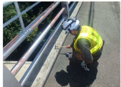
橋面上の点検
