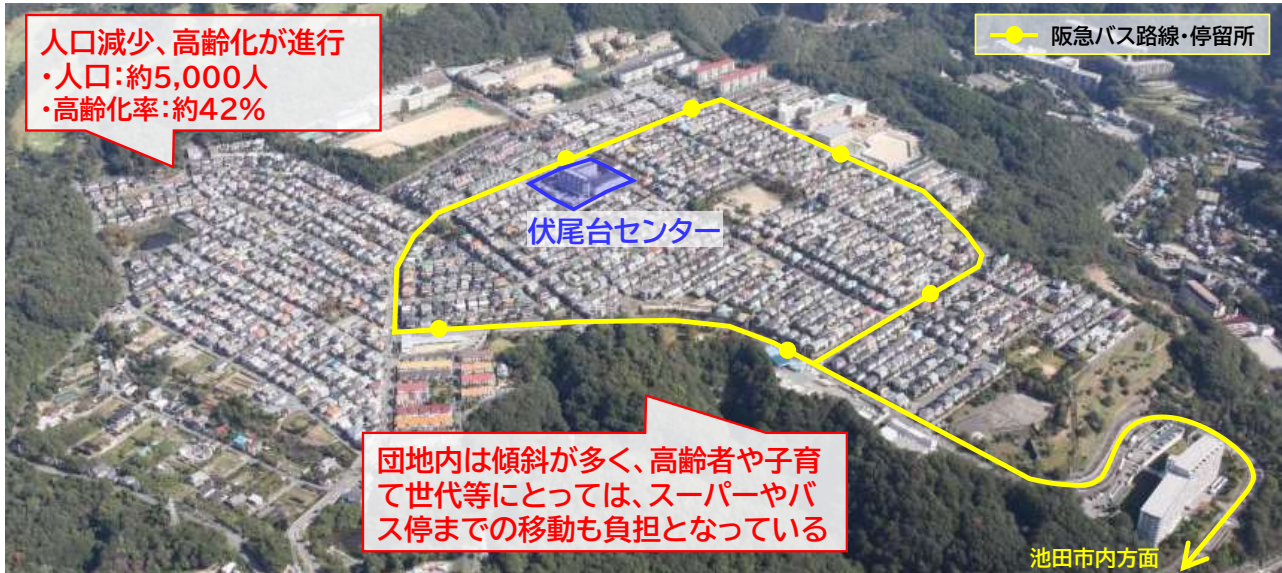
図 2-27 伏尾台地区の状況
