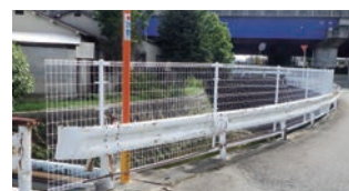
水路転落防止柵等設置事業【神田】
