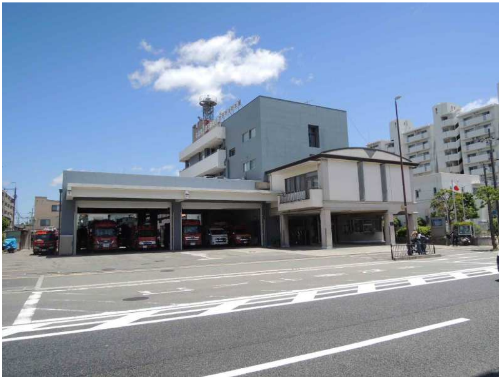
消防本部(署) 外観
