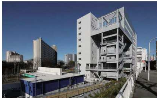
吹田市総合防災センター 訓練塔 出典:吹田市総合防災センターパンフレット
