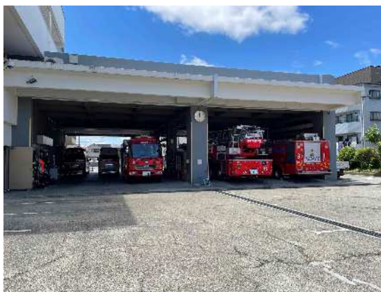
車庫(建物東側)
