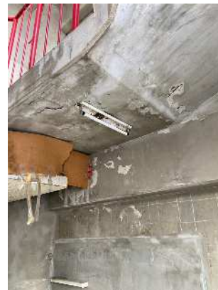
訓練塔内部(1F 天井部分)
