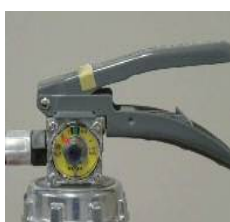
× 安全栓の脱落
