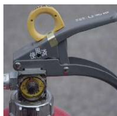
× 表示装置の脱落
