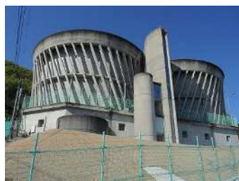
耐震性の確保が完了した畑配水池
