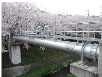
大阪広域水道企業団の水管橋
