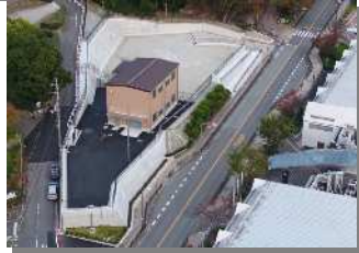
五月山緑地防災備蓄倉庫全景
