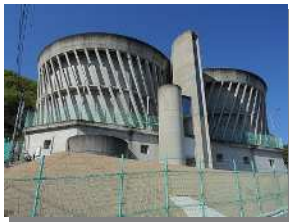
耐震性の確保が完了した 伏尾台配水場・畑配水池
