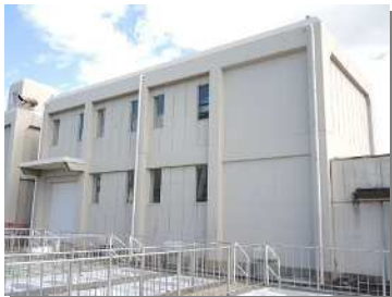
耐震性の確保が完了した 下水処理場 放流ポンプ棟
