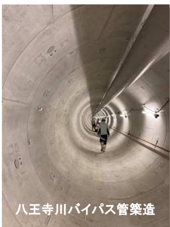
床上浸水対策施設の整備
