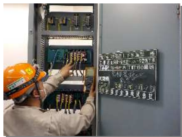
テレメータ更新工事
