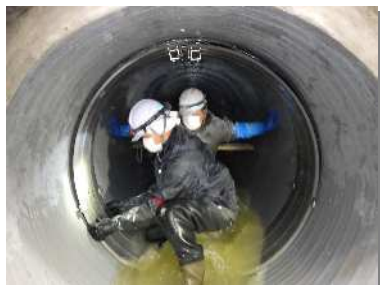
下水道管の管口部の 耐震化工事
