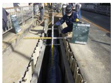
送水管の2系統化工事
