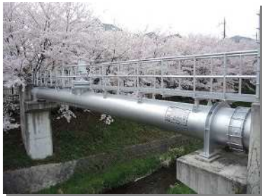
大阪広域水道企業団 の水管橋
