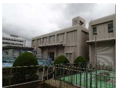
耐震化した下水処理場の 滅菌棟
