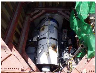
シールドマシンの 設置状況
