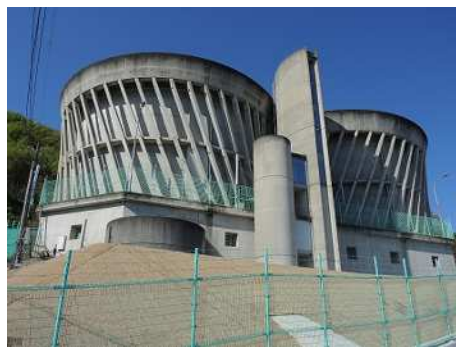
地震対策が完了した畑配水池
