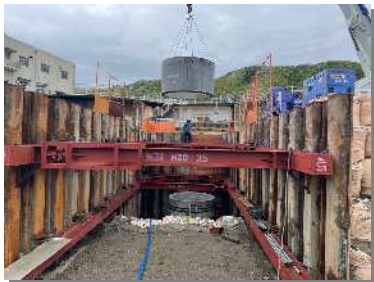
余野川取水設備更新工事
