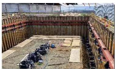
神田地区貯留施設築造工事
