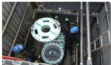
送水管の2系統化工事
