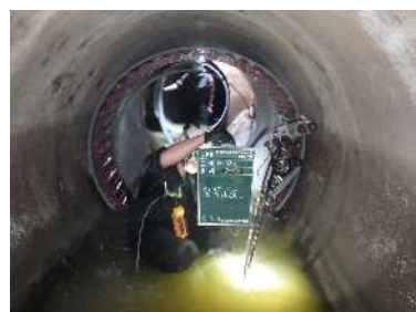
水道管の耐震化工事
