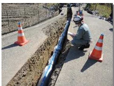
水道管の耐震化工事
