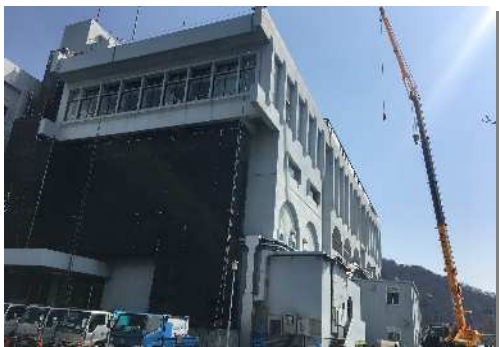
古江浄水場の耐震工事
