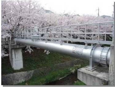
大阪広域水道企業団 の水管橋
