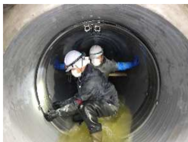
下水道管の耐震化工事
