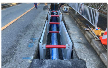
送水管の2系統化工事
