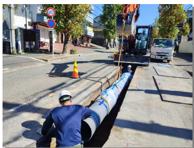
水道管の耐震化工事
