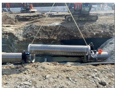
余野川取水設備更新工事
