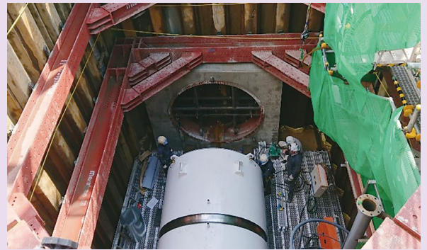
●雨水貯留施設のトンネルを掘る機械
