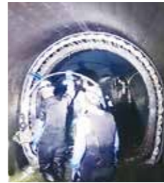
下水道管の改築工事
