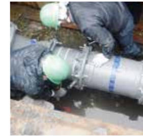
水道管の更新状況
