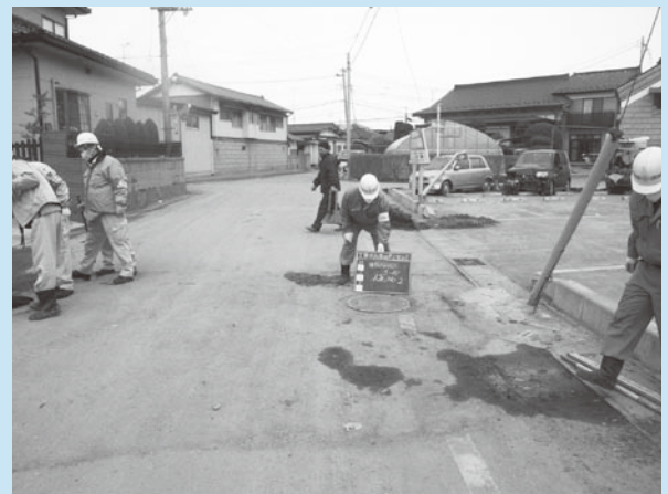
調査状況（多賀城市）
