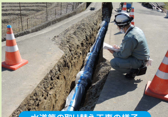
水道管の取り替え工事の様子
