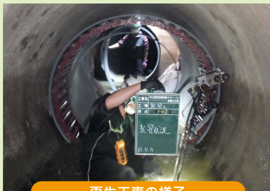
更生工事の様子
