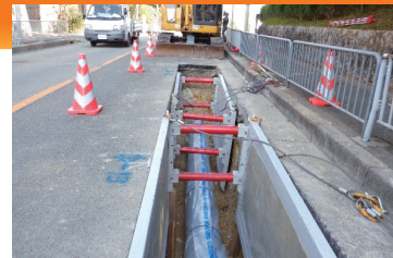
水道管取替工事の様子
