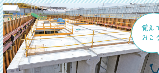
神田地区貯留施設築造工事の様子
