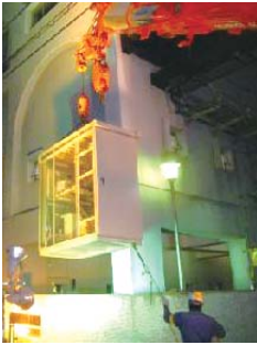
浄水場の更新工事
