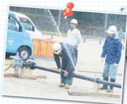
漏水修繕訓練①
