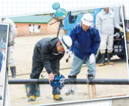
漏水修繕訓練②
