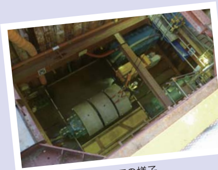
石橋第2増補幹線施工の様子
