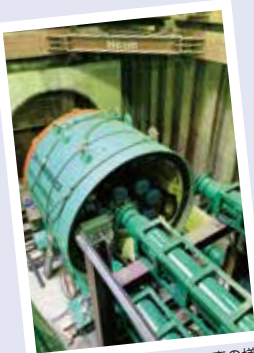
学大脇塚幹線貯留管築造工事の様子
