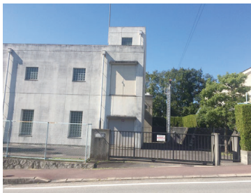
伏尾台配水場
