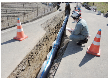
水道管取替工事の様子
