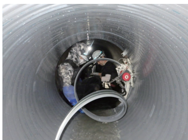
下水道管の更新工事の様子
