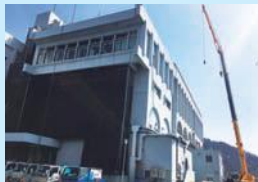
浄水場耐震化
