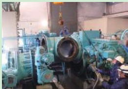
下水処理場ポンプ更新
