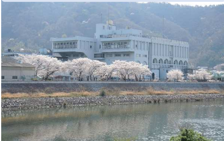
古江浄水場（昭和52年竣工）
