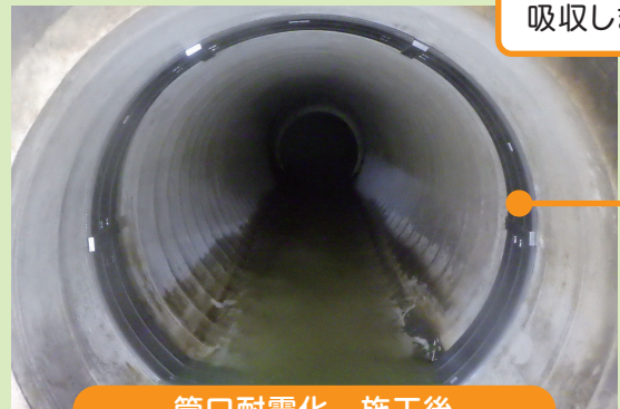
管口耐震化 施工後
