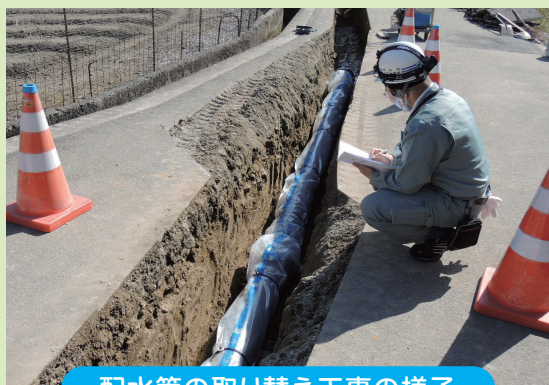
配水管の取り替え工事の様子
