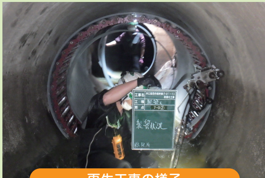
更生工事の様子
