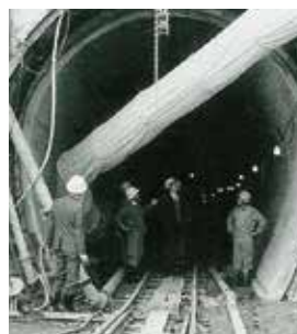
トンネル式配水池の築造
