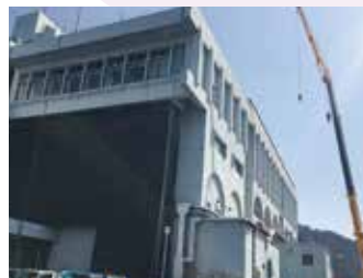
古江浄水場 耐震補強工事
