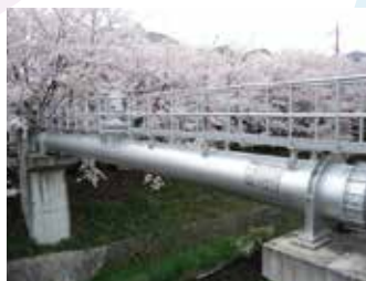
大阪広域水道企業団の水管橋
