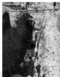
猪名川からの集水管敷設工事
