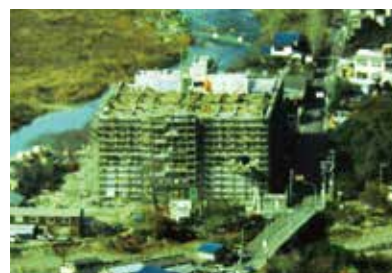
古江浄水場建設の様子
