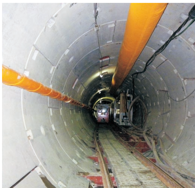
石橋第1増補幹線シールド工事（下水道事業）
