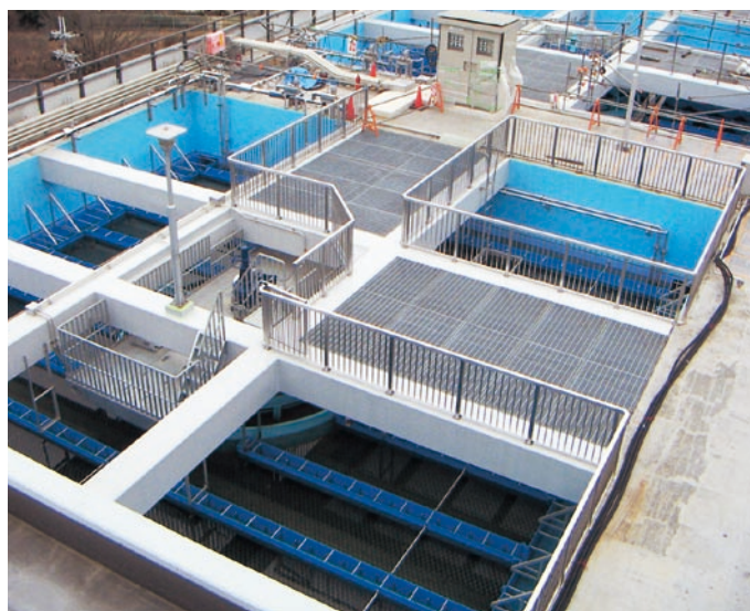
古江浄水場沈澱池設備改良工事（水道事業）
