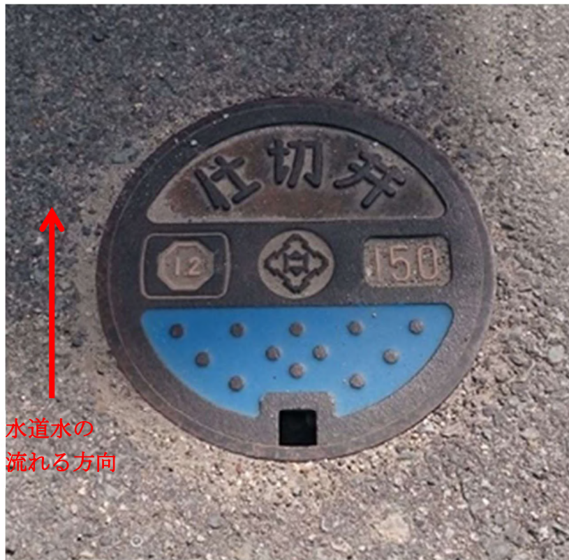
図4-51 仕切弁ボックス (円形1号) (口径 50~500mm)
