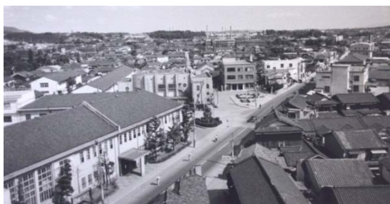
写真 2-24 国道 176 号(S36 頃)
