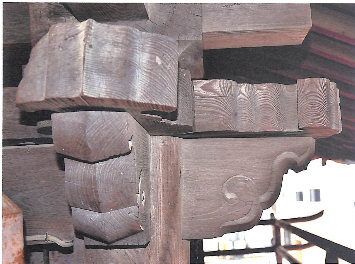
写真 11 鐘楼門 上階柱上頭貫木鼻、台輪
