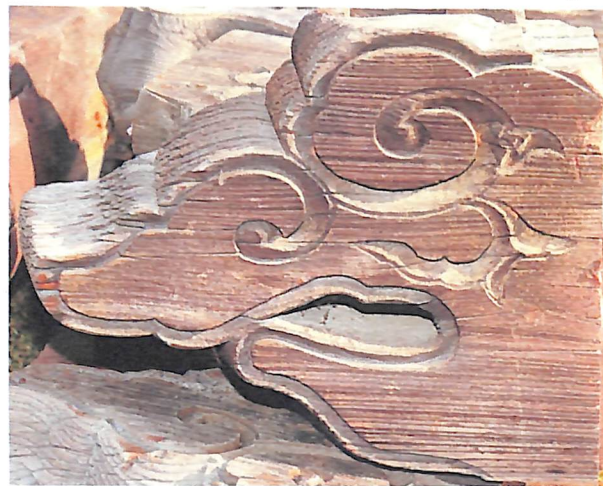
写真 10 鐘楼門 下階頭貫位置木鼻 (梁行)
