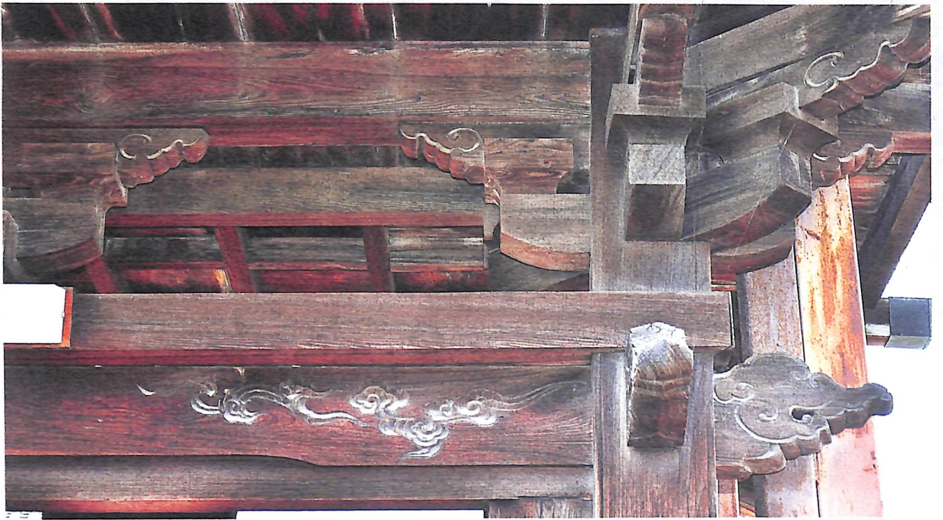
写真 7 鐘楼門 下階柱上部 (頭貫貫位置虹梁、木鼻、組物)
