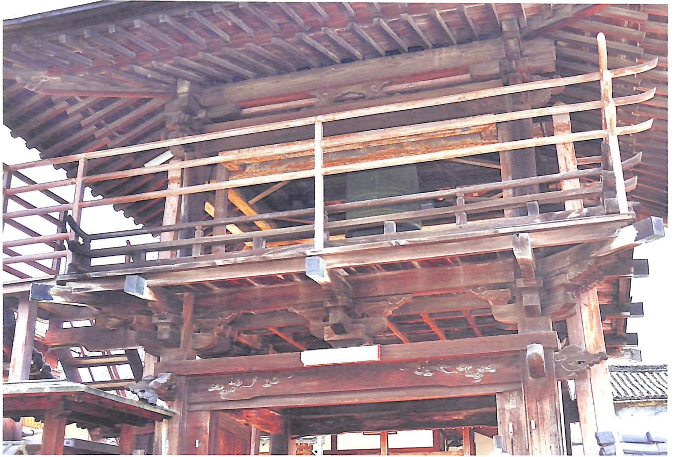
写真 3 鐘楼門 正面見上
