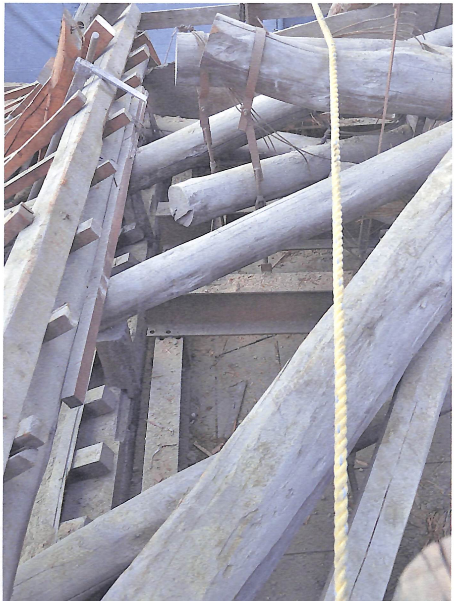
写真 14 鐘楼門 小屋組 (桔木、野垂木、化粧垂木、 端母屋など)
