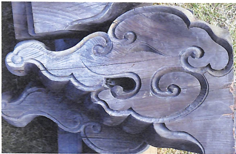
写真 9 鐘楼門 下階頭貫位置木鼻 (桁行)
