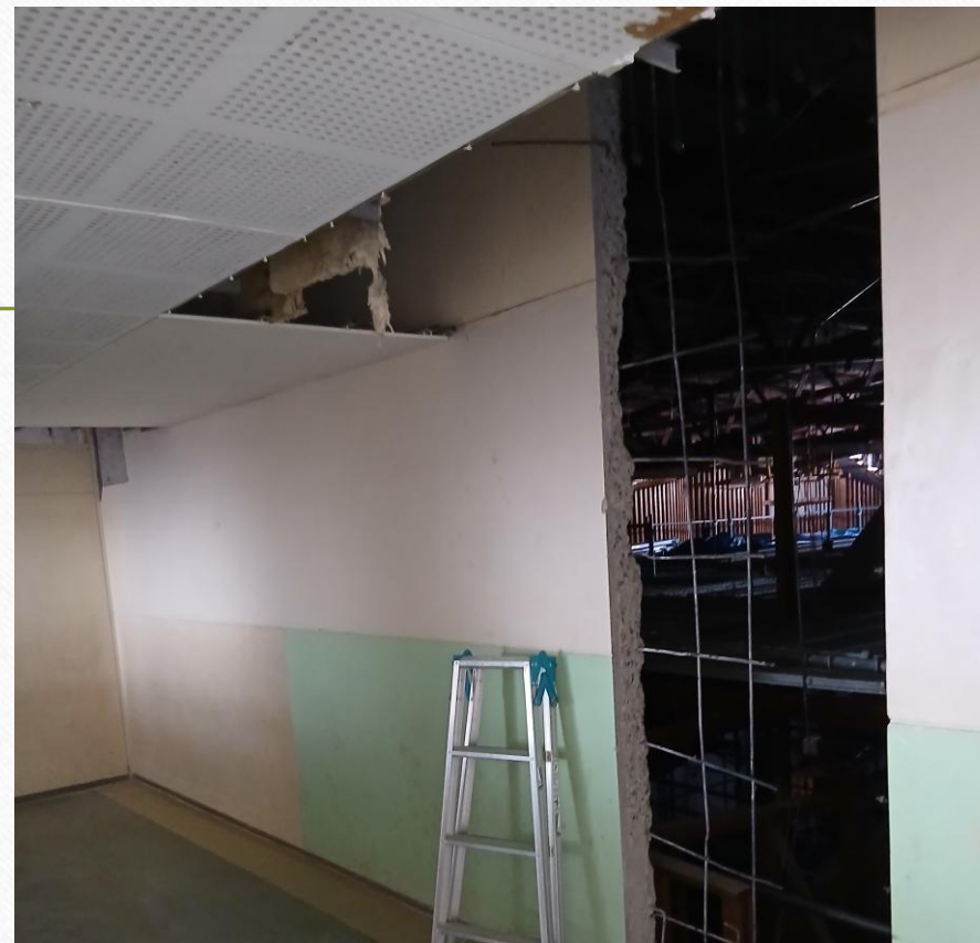
3階 図工室 カベ補強
