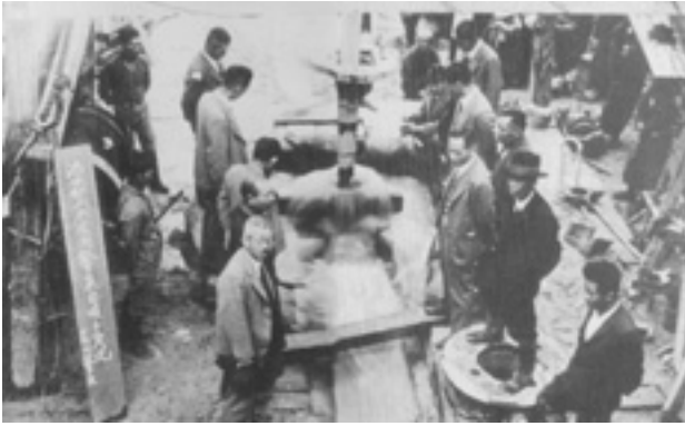
上水道の水源掘削工事（昭和12年、槻木町）
