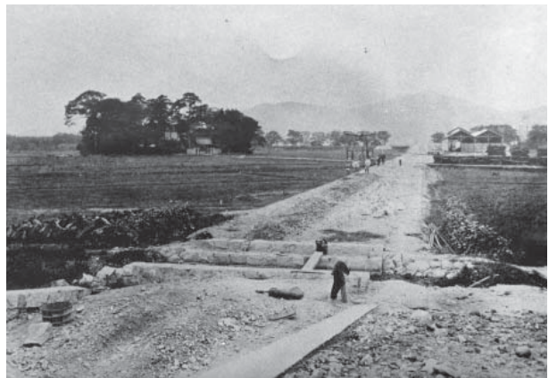
箕面有馬電気軌道の線路工事（明治42年ごろ）
