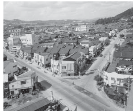
池田駅前の国道176号と桜通り（1961年）
