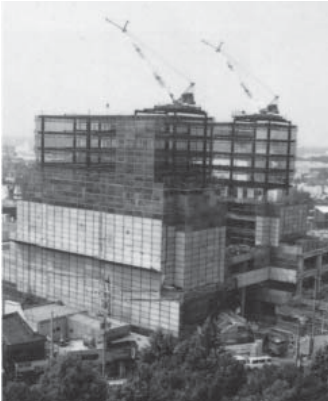
工事中のステーションN
