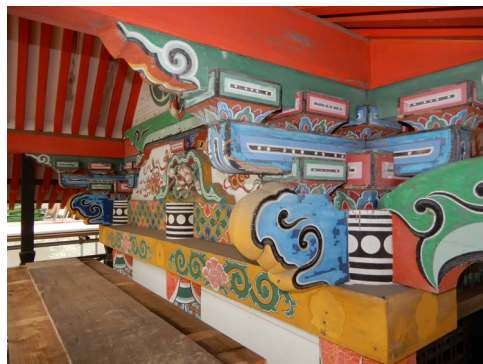
上塗が剥落し下塗が見える彩色
