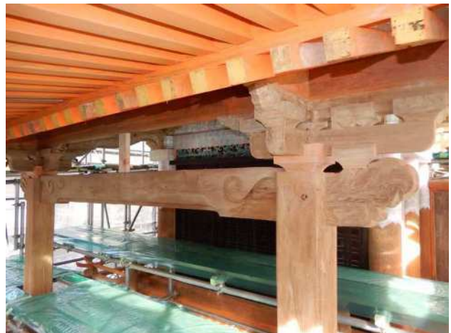
②単色塗と一部の彩色塗部分の掻き落とし状況
