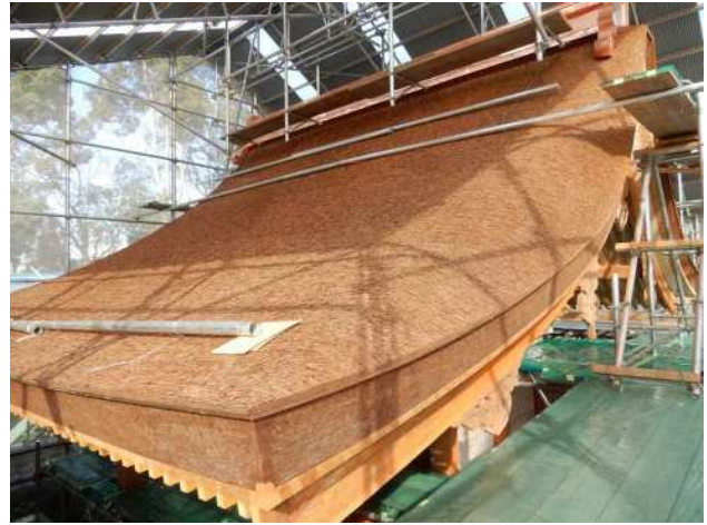
④屋檐檼皮葺完了
