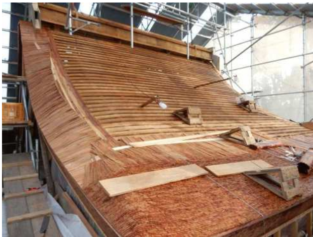
③屋根平葺部分の檜皮葺
