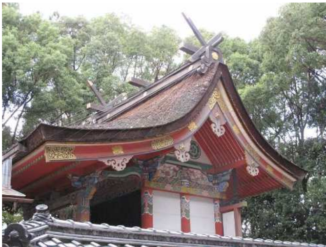
修理前の本殿正・側面外観
