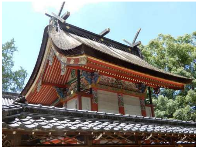
修理前の本殿背・側面外観
