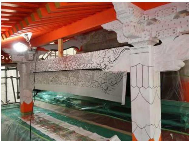
③彩色部分は最初に胡粉塗を行い文様の輪郭を写す
