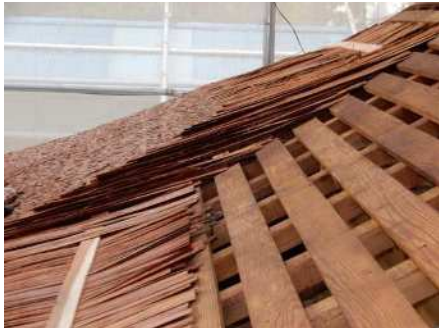
⑥檜皮葺は下地から約 10 cm の厚み
