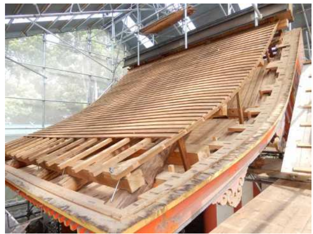
②檜皮材を取り除き屋根下地の状況
