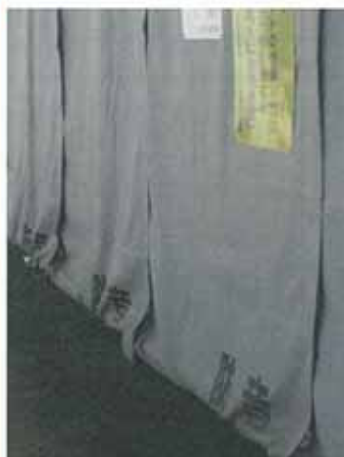
豊島東公園に設置された防音シート(上)
