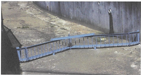
④今井水路改修事業 ゴミ取枠の移設(3月)
