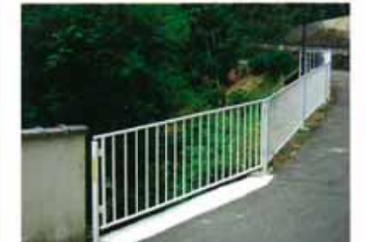
山の手公園北東側斜面に設置
