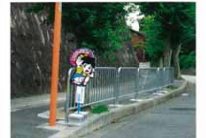
五月山教会幼稚園前の歩道に横断防止柵を設置
