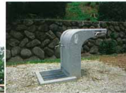
平成 23 年 6 月 山の手公園手洗場設置
