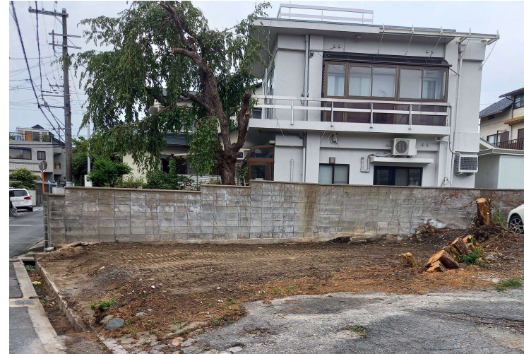
令和3年8月(除却後)の状況
