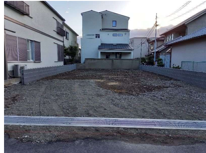
令和3年10月(除却後)の状況
