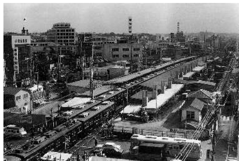
高架化工事が進む池田駅（昭和 56 年）
