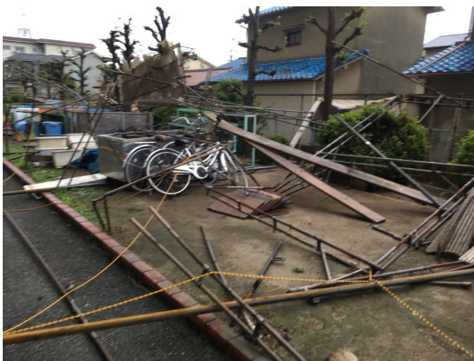
図 2-2 台風 21 号による被害の様子 (平成 30 年 9 月 4 日)
