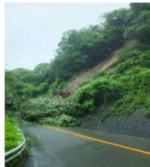
図 3-4 豪雨による被害の様子 (2018 年 7 月 5 日～8 日)
