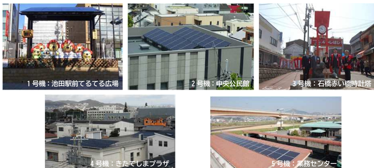
図 2-16 市民共同発電所
