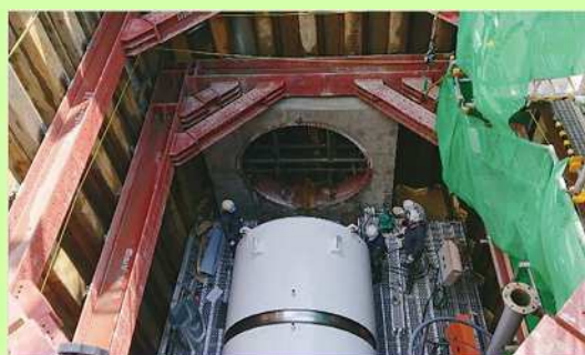
雨水貯留施設のトンネルを掘る機械
