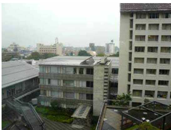
大学の屋根に設置した太陽光発電
