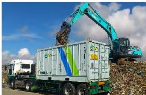
仮置場での海上コンテナへの積込
